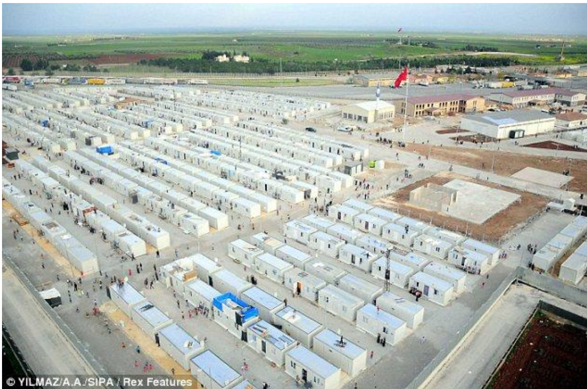
KAHRAMANMARAŞ Κέντρο Στέγασης Προσφύγων
